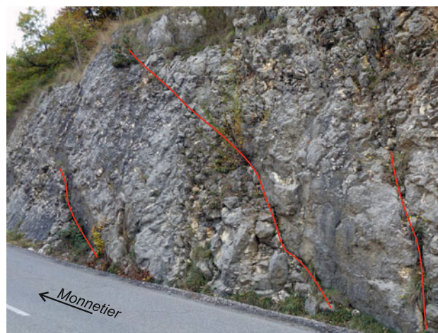
Fig. 6 Plans de faille parallèles à l'axe de la structure du Salève, dans les Calcaires urgoniens le long de la D41, entre la sortie nord du village de Mornex et le réservoir à l'entrée du vallon de Monnetier
